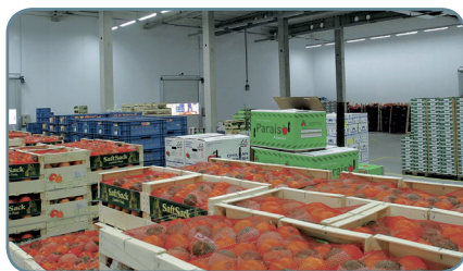
Использованы светильники ДСП52-32-101 Optima, Ежс>200лк Для дежурного освещения использован светильник ДБО86-12-041 WM EM1
